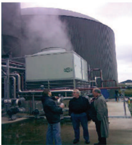
2.5 兆瓦生物氣體廠，位於比利時
