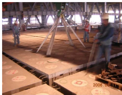
(d) Position the full precast slabs
