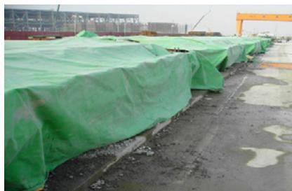
(б) Паровая обработка вафельных пластин
