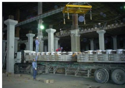
(б) Поднимайте сборные вафельные плиты с помощью мостовых кранов.
